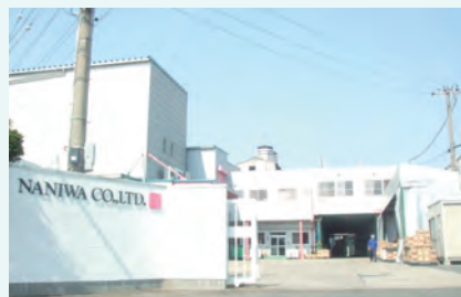
愛知県みよし市にある本社／工場
